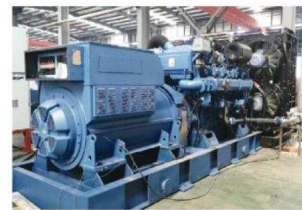
泰安污水厂项目 Tai'an sewage treatment plant
